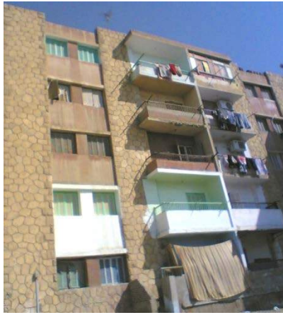
شكل (٤-٢٦) مباني منطقة الصباح وإستخدام الحجر في التشطيبات الخارجية
