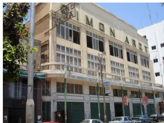
شكل (٣- ٢٥) مبنى سيمون أرزت عام ١٩٢٠م وعام ٢٠٠٩م وهو من المباني ذا الاستخدام التجاري السياحي.
